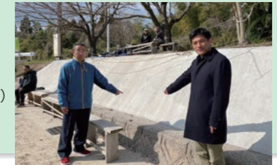
小山田農村広場の法面がコンクリートになり施設の長寿命化が図られました。
